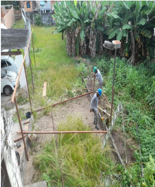
Figuras da execução do barracão da obra.
