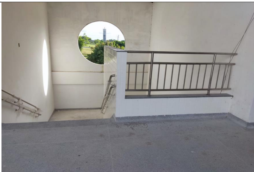
Parapeito escada 2 – pavimento superior – comprimento 1,93 metros
