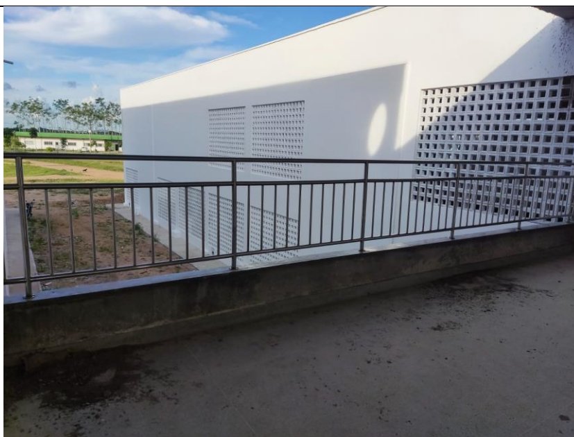
Jardim 3 – pavimento superior – 7,66 metros
