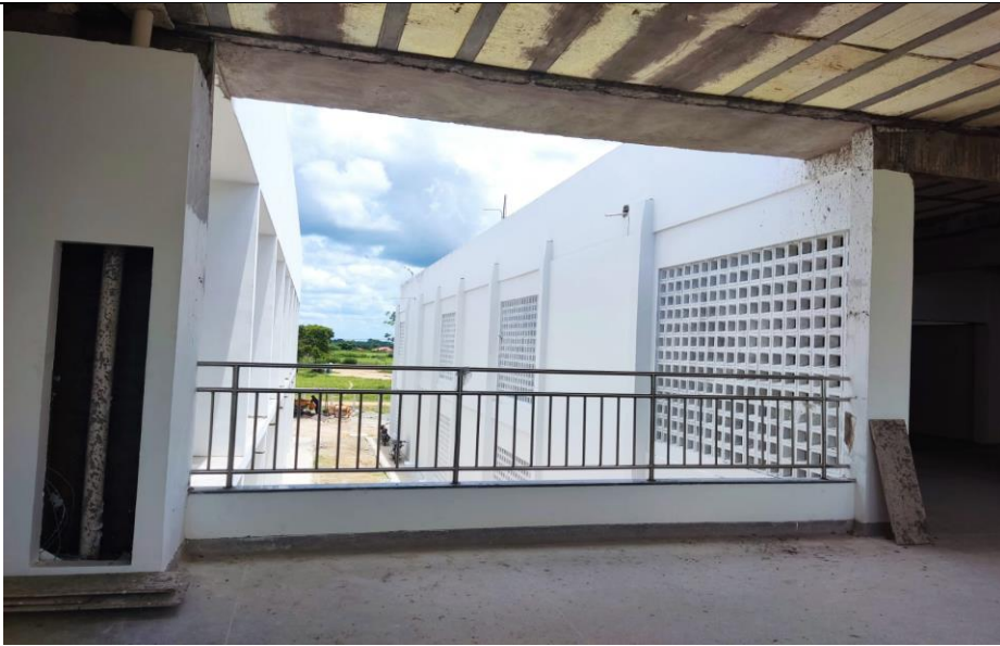
Jardim 2 – pavimento superior – comprimento 4,75 metros
