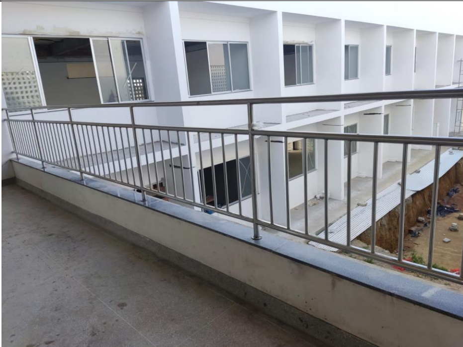
Jardim 1 – pavimento superior – comprimento 7,65 metros
