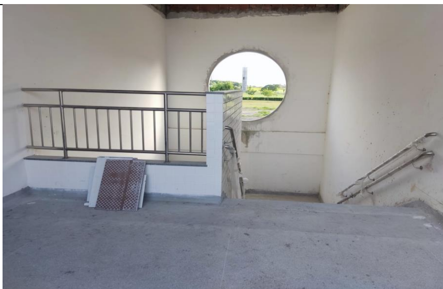
Parapeito escada 1 - pavimento superior – Comprimento 1,93 metros
