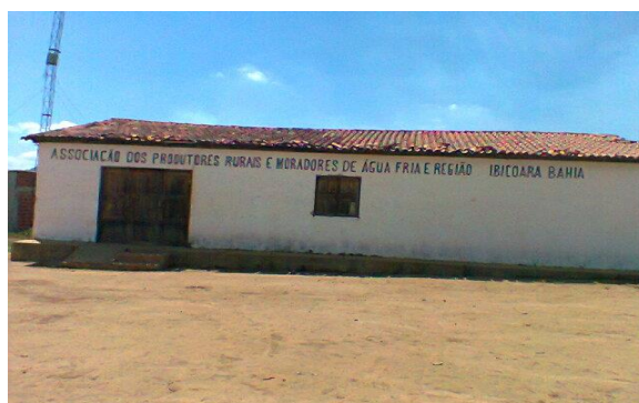
Figura 4. Visão panorâmica da sede da Associação dos Produtores e Moradores de Água Fria e Região. Mucugê e Ibicoara, BA, 2013. Foto: Walter. S. M. Júnior
