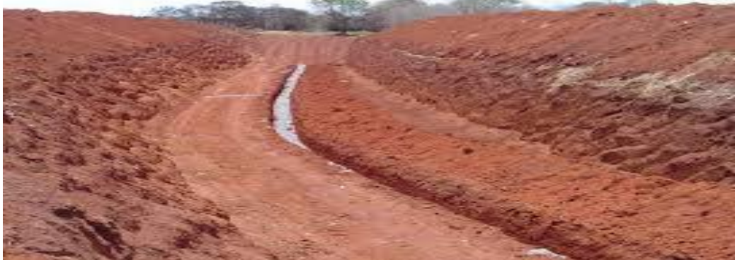
Figura 04 – Aterro Controlado (AC)
