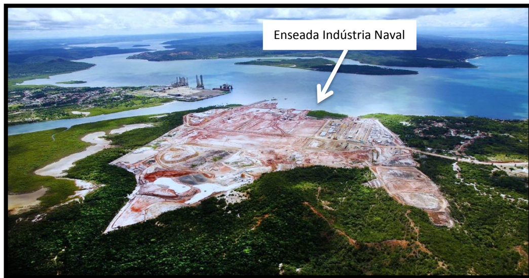
Figura 06- Empreendimento em fase de construção Fonte: Constran.com.br
