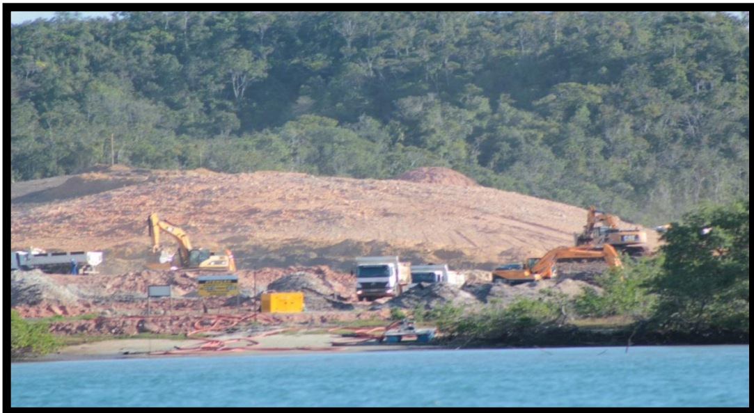
Figura 07 - Imagens da Terraplanagem na área do Empreendimento Fonte: Arquivo particular do pesquisador, 2012.
