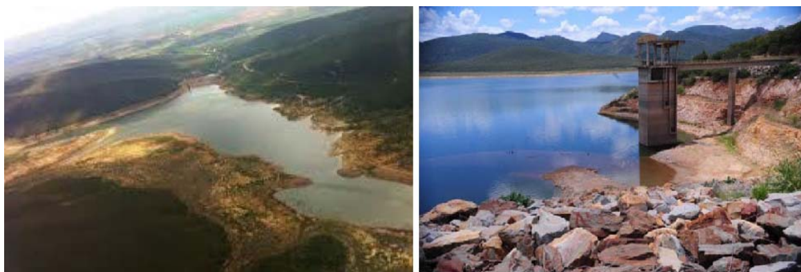
Figura 35: Reservatório de Mirorós e a Torre de Tomada D'água.
