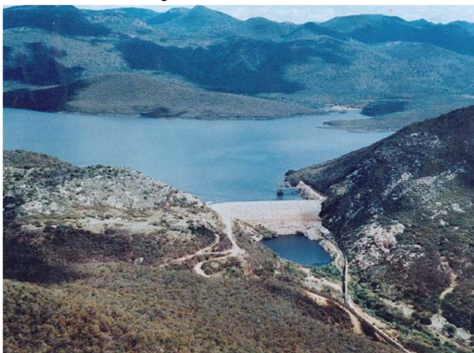
Figura 21: Vista aérea da barragem e do reservatório de Mirorós
