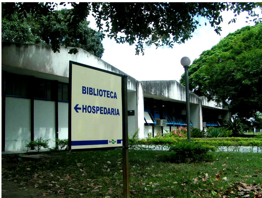
Figura 4: Entrada Principal Biblioteca Archimar Bittencourt Balleiro Fonte: Léa Cunha, 2008.
