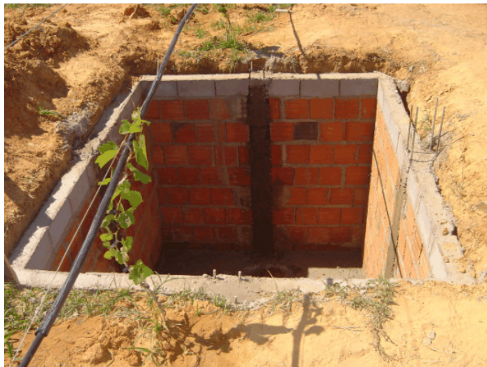
Figura 2 – Parede de alvenaria com colunas de concretos para receber o sistema lisimétrico.
