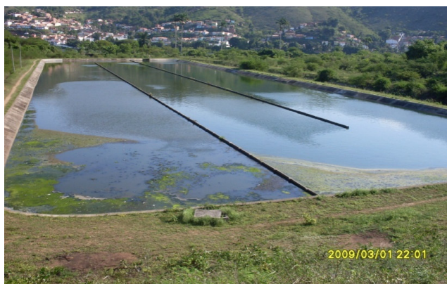
Figura 04 – Estação de tratamento de esgoto da Embasa/Cachoeira
