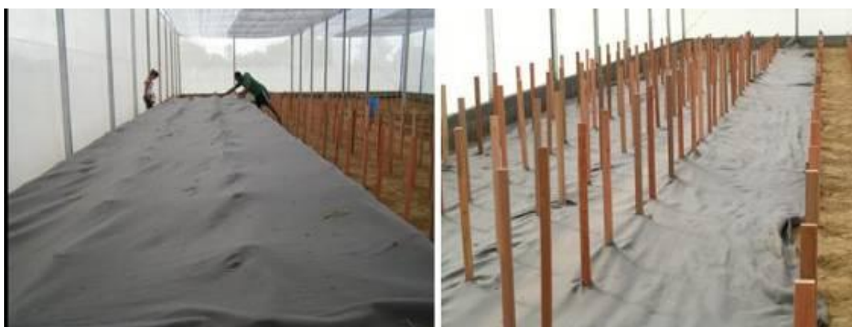
Figura 4. Alocação da manta geotêxtil no piso da casa-de-vegetação
