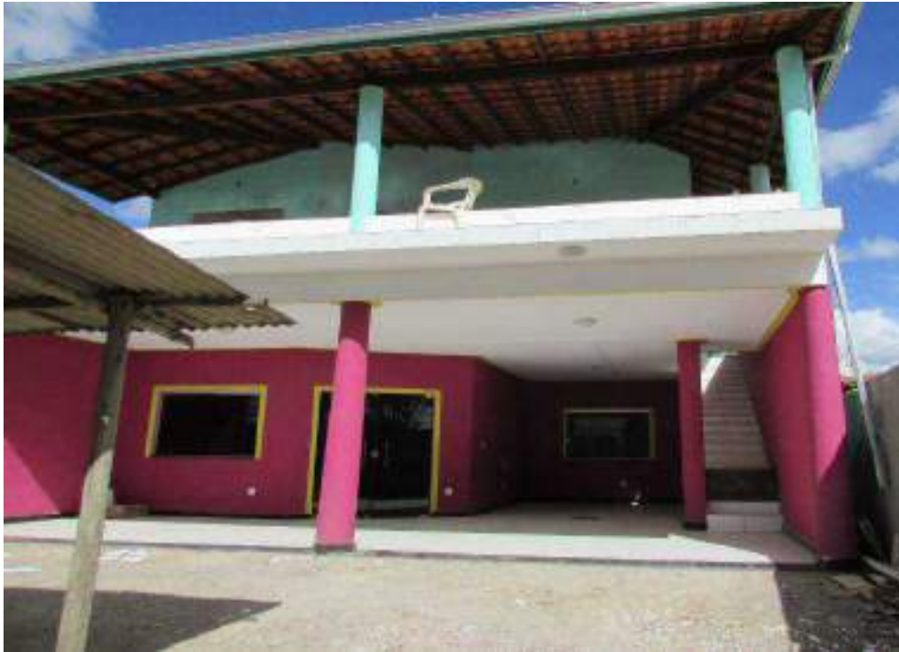
8- Casa em construção de uma das ciganas evangélicas.
