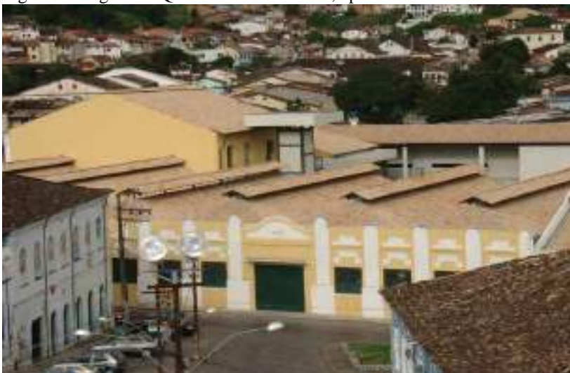
Figura 5 Imagem do Quarteirão Leite Alves, após a reforma
