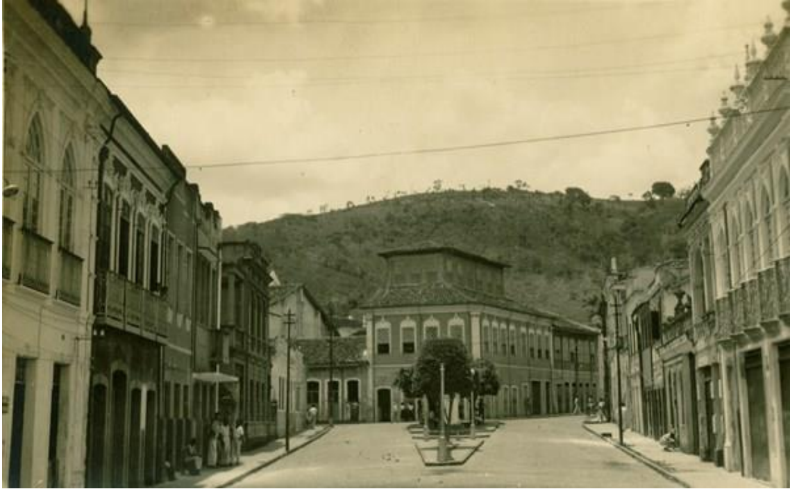
Figura 3: Casa comercial Mansur, à frente. Fonte: IBGE
