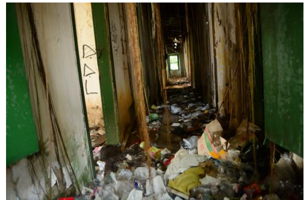
Figura 25- Vista interna do casarão- corredor.
