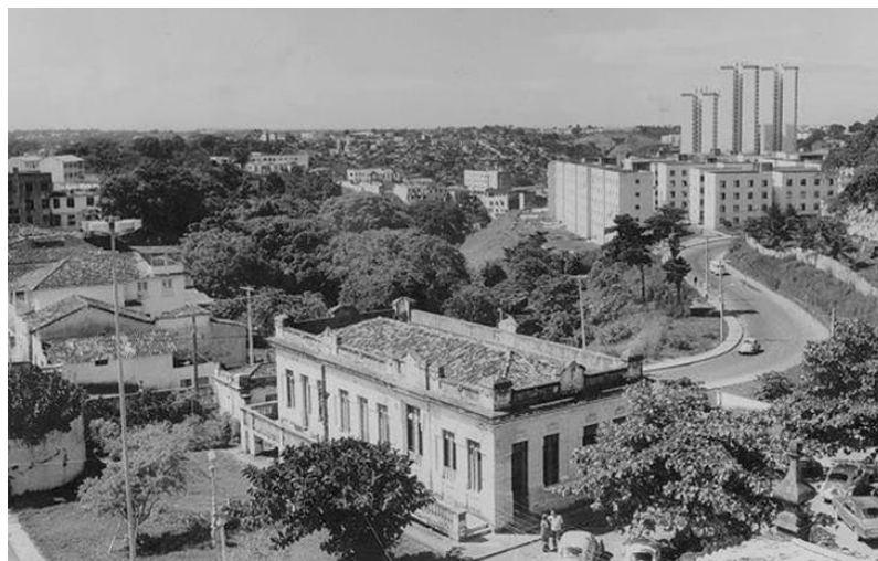
Figura 13- Vista dos pavilhões do hospital Juliano Moreira.
