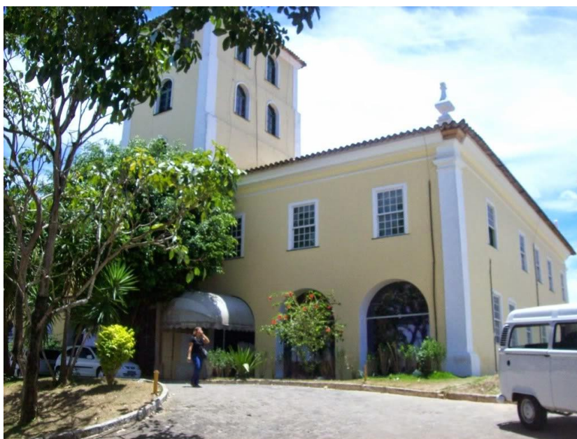
Figura 16- Fachada noroeste do Solar Boa Vista- Anos 2000.
