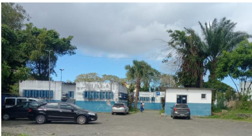
Figura 29- Fachada Centro de Saúde Mental Aristides Novis.
