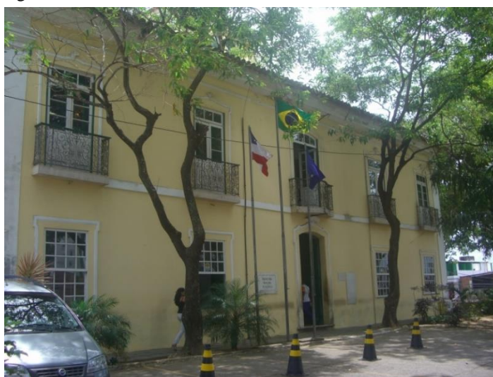
Figura 17- Fachada nordeste do Solar Boa Vista, nos anos 2000.
