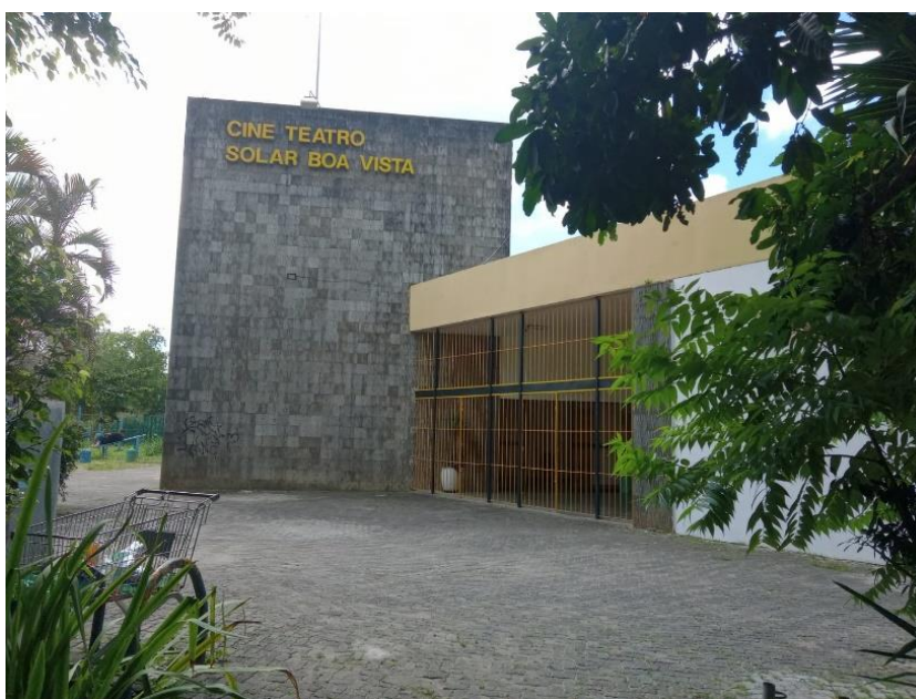
Figura 28-Fachada Cine Teatro Solar Boa Vista.
