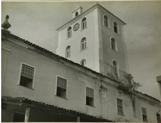
Figura 10-Fachada sudoeste do Solar Boa Vista.
