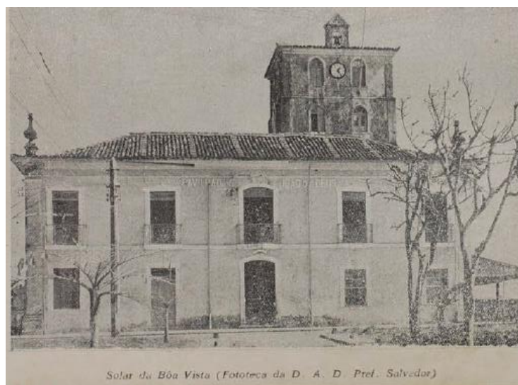
Figura 3- Fachada do Hospital São João de Deus no início do século XX.
