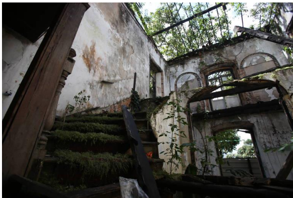
Figura 24- Vista interna do casarão- escadaria.
