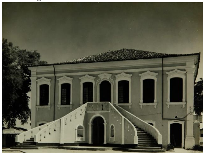
Figura 19- Fachada do Solar Conde dos Arcos.
