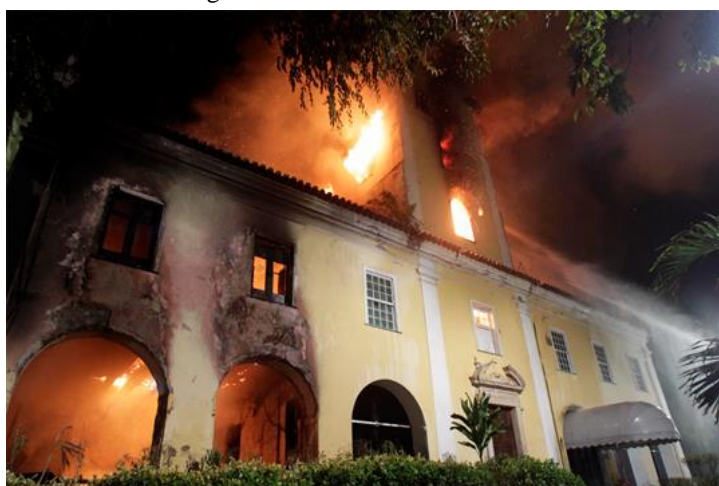
Figura 22- Incêndio Solar Boa Vista.
