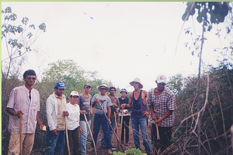
Mutirão para o preparo da área para a construção da sede da EFASE na comunidade Lagoa do Pimentel. Foto: Veronilde Oliveira da Costa.
