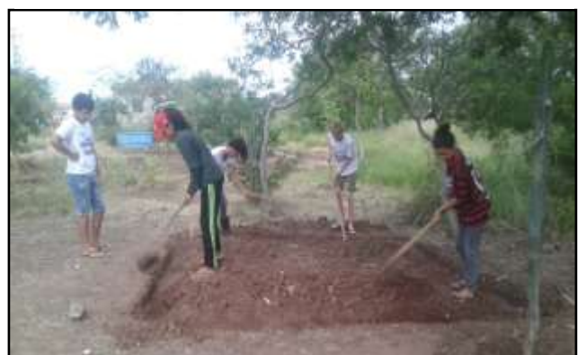
Figura 21 - 6ª Ação: Construção da Casa Pedagógica de Sementes Crioulas
