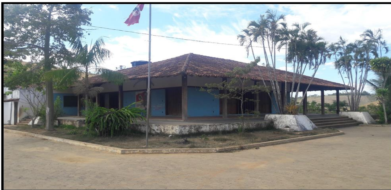
Figura 06: Casarão/ sede do Assentamento, que dos anos de 2002 à 2016 funcionou a EMEIEF Assentamento “Zumbi dos Palmares”:
