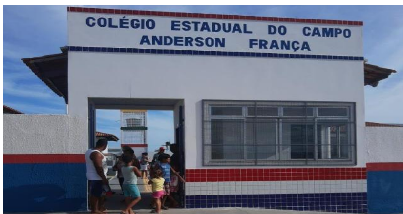
Figura 7: Fachada do CECAF:
