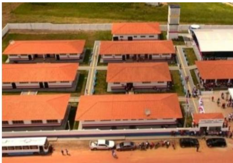
Figura 8: Estrutura física do CECAF:
