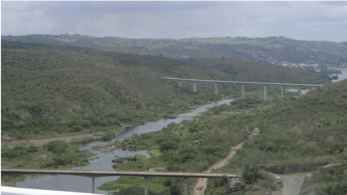
Figura 3.4: Assoreamento 36 do Rio Paraguaçu após o seu represamento Fonte: Arquivo da autora, 2012
