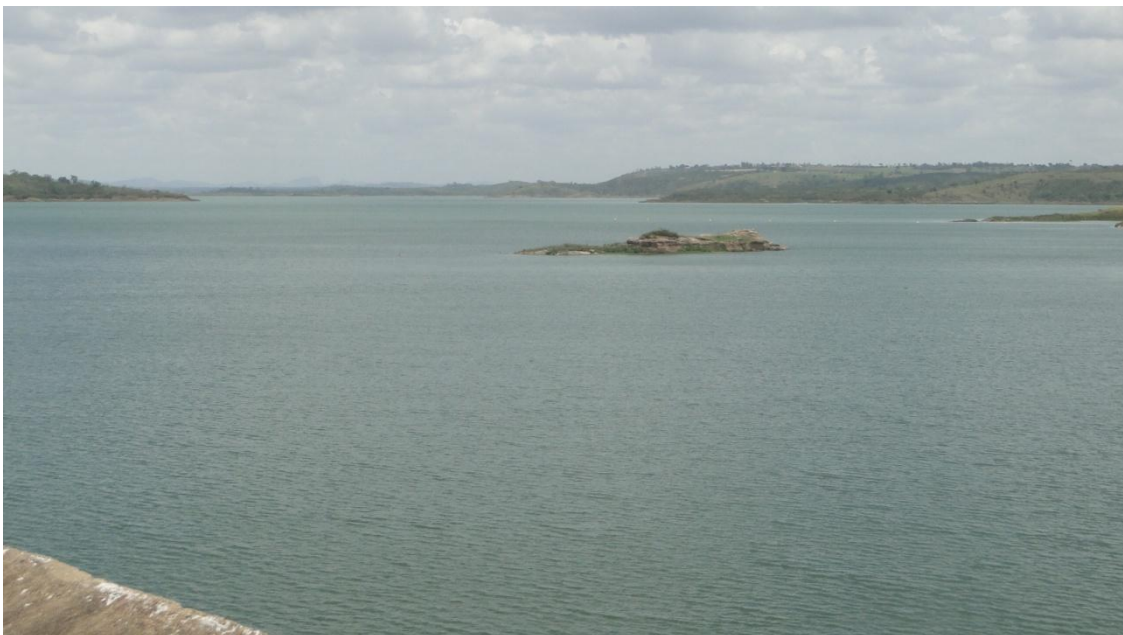
Figura 3.3: Lago da Barragem e Usina Pedra do Cavalo
