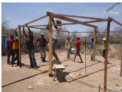
Galinheiro sendo construído pela comunidade
