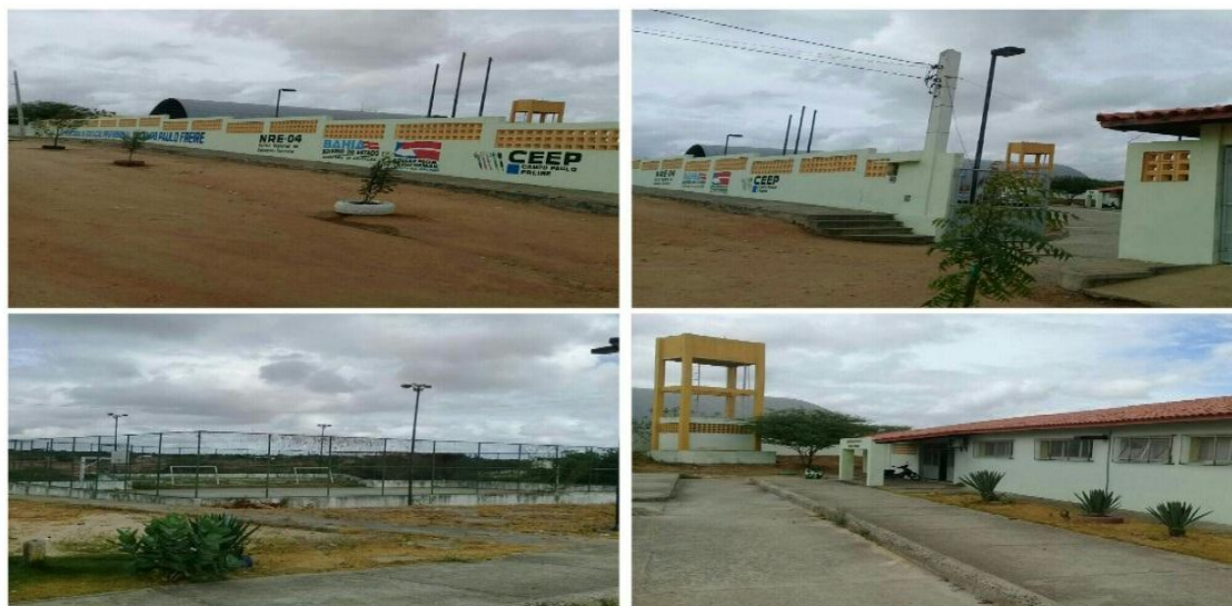
Figura 3 - Fotografia – Estrutura Física do CEEP CAMPO Paulo Freire
