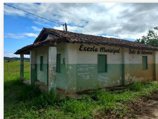
Imagem: Escola fechada no Campo, região do São Sebastião, São Miguel das Matas. Fonte: arquivo pessoal
