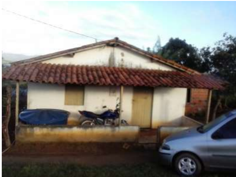
Figura 01 – Foto da casa de Dona Dos Anjos, mãe da pesquisadora. Fonte: Acervo da autora, 2017.
