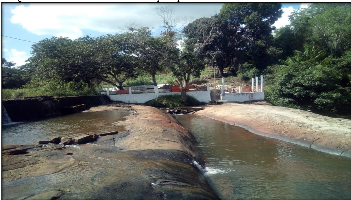
Fotografia 05: ruínas de um dos maiores quiosques demolidos.
