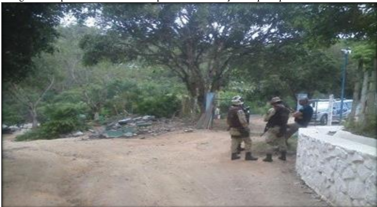
Fotografia 09: policiais militares acompanham a demolição de quiosques no local.
