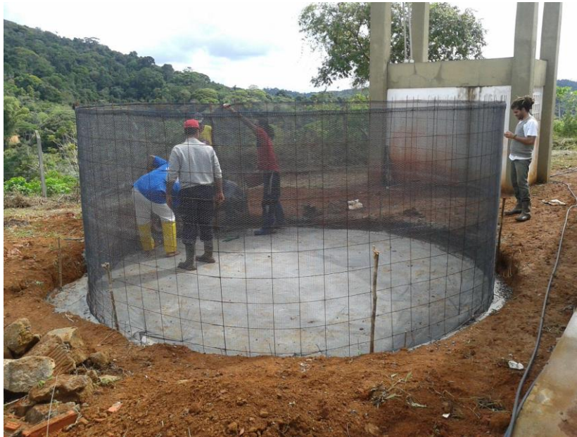
Figura 2: Construção da Cisterna do Sistema de Captação de Água da Chuva (SAAC). (Fonte: Acervo ETALC, 2016)
