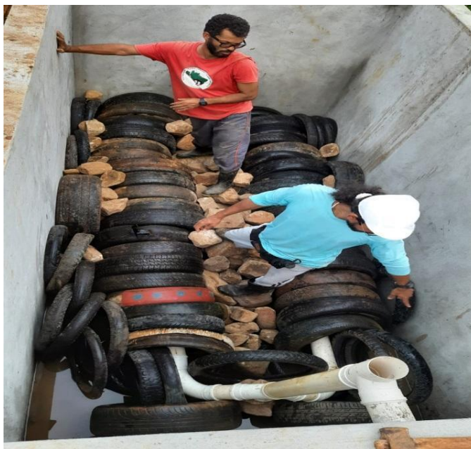
Figura 10: Implementação da Bacia de Evapotranspiração, na ETALC. (Fonte: Autor, 2022)
