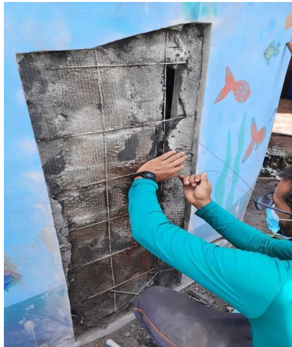
Figura 3: Manutenção da Cisterna do SAAC. (Fonte: Autor, 2022).
